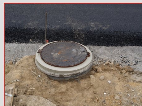
Hotový, vyrovnaný šachtový rám
