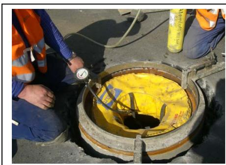
Einsetzen der Schlauchschalung und aufblasen bis max. 0,3 bar
