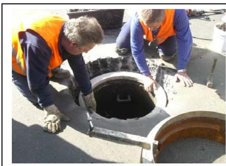
Versetzen eines Ausgleichsringes in ERGELIT-SBM
