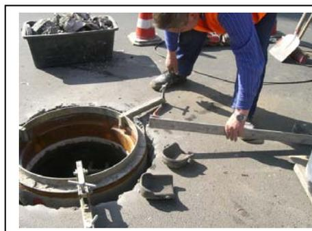
Ausrichten des Rahmens mit dem Niveaualter
