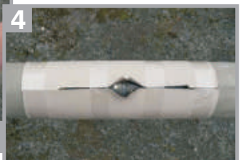
4 Eingeschalte Schweißnaht des Stahlrohres
