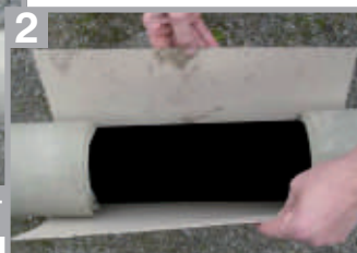
2 Der Spezialkarton wird als Schalung um die Stahlleitung gelegt
