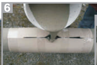
6 Eingießen des klumpenfreien ERGELIT-NUM in die Schalung
