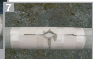
7 Fertig vergossene Schweißnaht in der verlorenen Schalung
