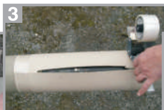
3 Die Schalung wird mit einer Klebefolie an den Enden fixiert
