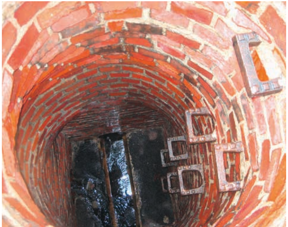
Bild 3 und 4: Betonschacht und Klinkerschacht nach der Reinigung
