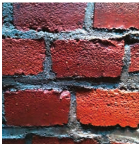
Bild 5: Mauerwerk nach Bearbeitung mit dem Wasser-Sandstrahlgerät HDS-jet
