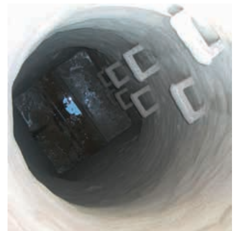
Bild 7: Ausgeschleuderter Klinkerschacht
