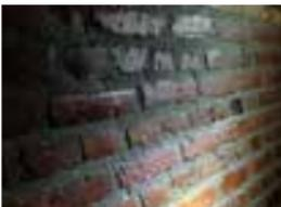
Druckverfugte und gesäuberte Klinker
