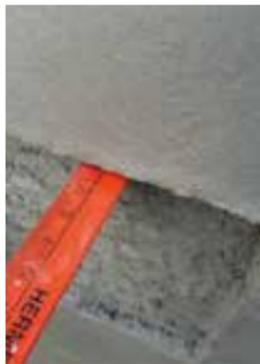
10 mm Schichtdicke der frisch gespritzten Beschichtung der „Spritzrauen“ Oberfläche
