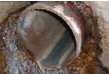
Wassereinbruch an Rohranbindung
