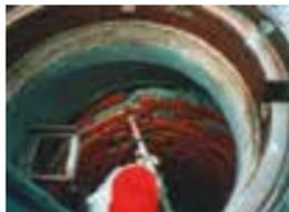
Druckverfugung im Schacht während der Verfugung mit ERGELIT-KS1
