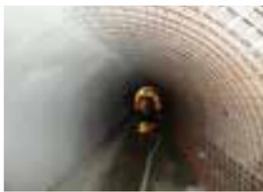
Spritzmörtel werden schichtweise aufgetragen, entweder im gleichen Arbeitsgang bei wiederholtem Überspritzen der gleichen Fläche, oder in einem späteren Arbeitsgang, nach einer Arbeitsunterbrechung. Bei einer längeren Arbeits-
