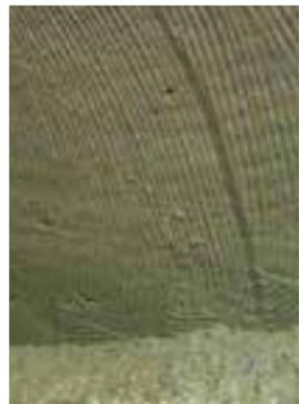
Mit Zahnpachtel strukturierte Oberfläche bei Arbeitsunterbrechungen zwischen 2 Schichten
