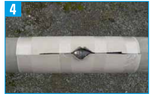
4 Eingeschalte Schweißnaht des Stahlrohres
