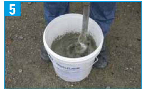
5 ERGELIT-NUM und Wasser wird homogen, fließfähig angemischt
