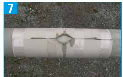
7 Fertig vergossene Schweißnaht in der verlorenen Schalung
