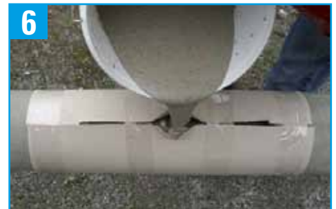
6 Eingießen des klumpenfreien ERGELIT-NUM in die Schalung
