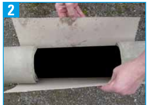
Der Spezialkarton wird als Schalung um die Stahlleitung gelegt
