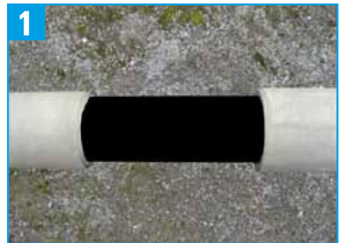
Die FZM-Stahlleitung mit der nachzuisolierenden Schweißnaht
