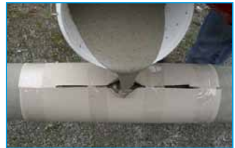
Eingießen des klumpenfreien ERGELIT-NUM in die Schalung
