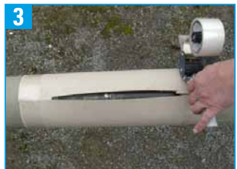
Die Schalung wird mit einer Klebefolie an den Enden fixiert
