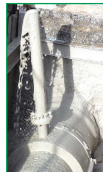
Injection de vide annulaire entre Ø 600 et Ø 800 sur 2x400 m
