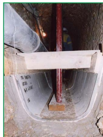
**Blocage de coques rigides PRV, GRC, béton-composite, partielles ou intégrales**
