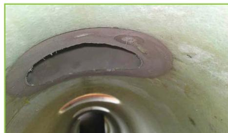
Raccordement réhabilité avec ERGELIT Kanaltec CF
