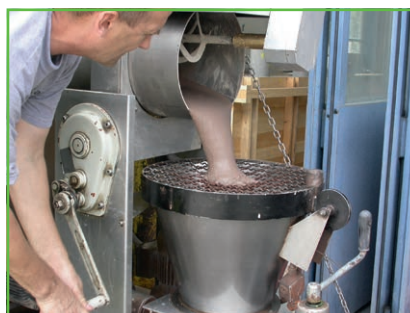
Déversement du mortier préparé à bonne consistance dans la pompe
