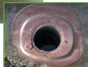
ERGELIT-Kanaltec cf après 10 ans
