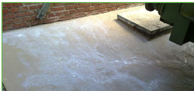
Revêtement avec ERGELIT-OED
