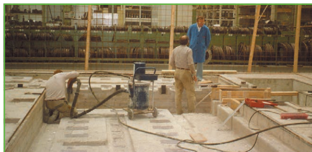
Bassin revêtu avec ERGELIT-OED
