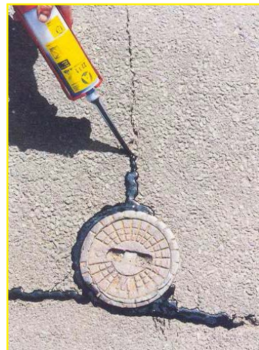
Fissure autour d'élément de voirie
