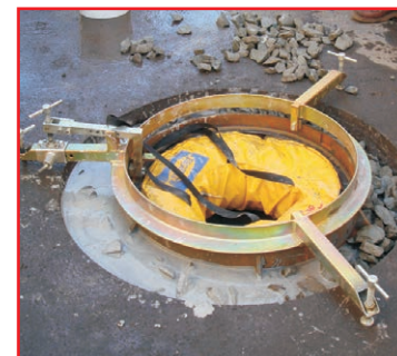
Prise du mortier
