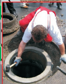
Pose de rehausse
