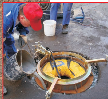
Positionnement et coulage
