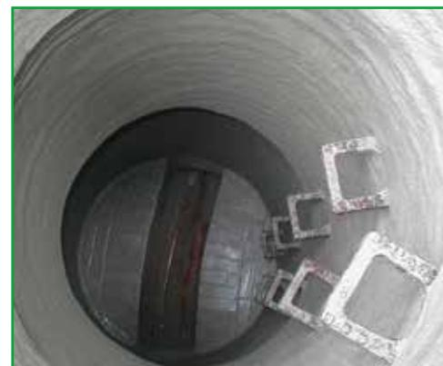
KS-ASS® est un procédé de réhabilitation des regards de visite et autres ouvrages verticaux de profondeur jusque 25 m. Moyennant l'emploi d'une tête de projection par centrifugation, les mortiers ERGELIT-KS (mortiers de cuvelage et anti-corrosion disponibles en divers degrés de protection) peuvent être projetés par couches successives jusqu'à l'épaisseur souhaitée (au moins 7 mm). Les ouvrages sont ainsi non seulement protégés contre la corrosion mais aussi statiquement renforcés.
