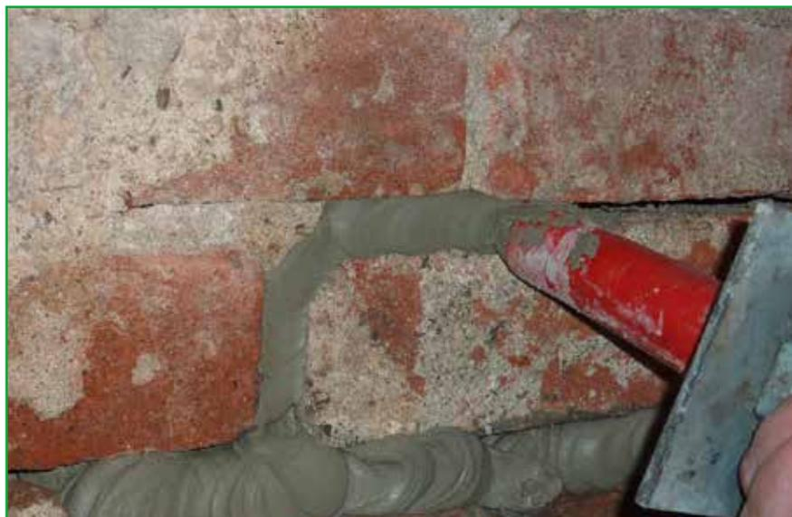
Le rejointoiement de maçonnerie par injection de mortier ERGELIT-KBi en cordon extrudé pérennise vos ouvrages maçonnés. Les fractures, fissures et joints sont remplis sous pression avec une canule. Les joints ainsi reconstitués sont étanches, solides et résistants à la corrosion. En solution alternative, ERGELIT-KS 1 pour les réseaux urbains et ERGELIT-KS 2 pour les réseaux industriels peuvent être employés pour le rejointoiement.
