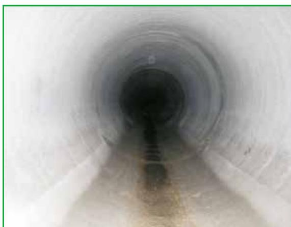
Pour réhabiliter l'intrados complet des canalisations, la projection centrifugée de 7 à 40 mm de mortiers ERGELIT-KS (adapté au domaine de corrosion) est une solution adaptée.
